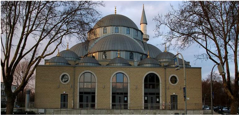
Figure 1. Marxloher Merkez Mosque, ("Merkez Moschee, Marxloh", 2011)
